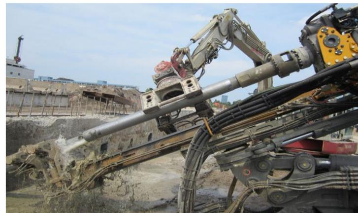
**Prediligono l'utilizzo di pinze meccaniche, montate su mini escavatori, per la movimentazione delle aste di perforazione.**
